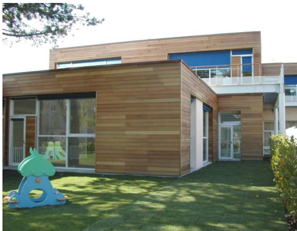
Crèche collective avec parements en bois Grande rue – quartier du Petit Garches
