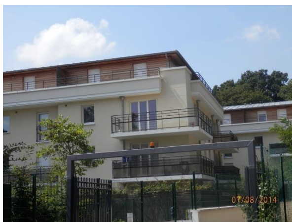
Immeuble social dans la cité Poincaré
