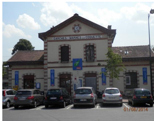
Gare SNCF « Garches / Marnes-la-Coquette »
