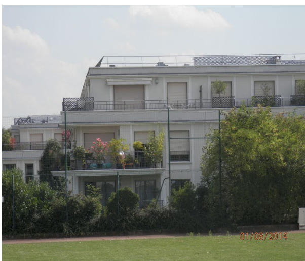
Immeuble Arboretum – Résidence privée
