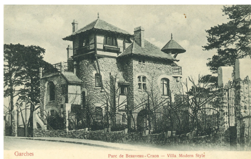
Garches, parc de Beauvau Craon, Villa Modern Style, début 20 e siècle, archives municipales, 1Fi8.
