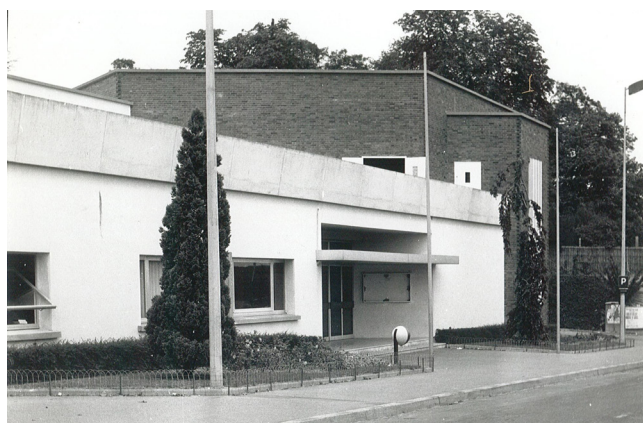
Façade du Centre Culturel, photographie, 1972, archives municipales de Garches.
