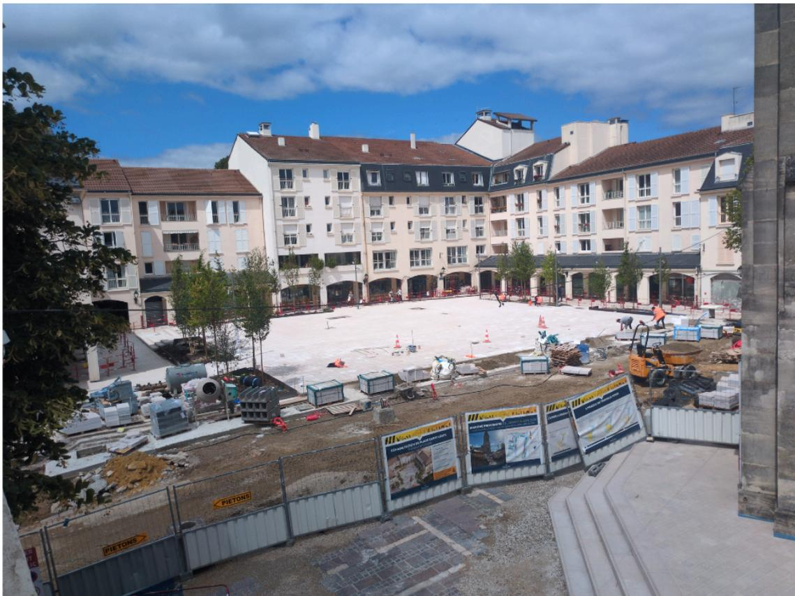
La pose de la pierre de comblanchien sur le carré du marché est réalisée à 90 %.
