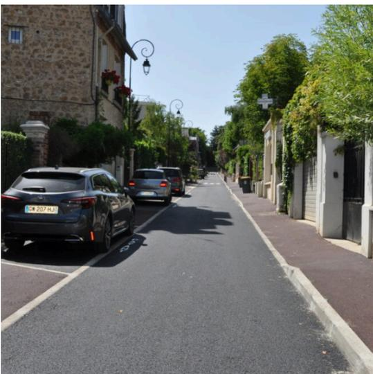
Les **deux tronçons** de la rue de Villeneuve sont désormais finalisés. Travaux réalisés : reprise complète de la chaussée, enfouissement des réseaux, raccordement à la fibre, création de places PMR et deux-roues, végétalisation et stationnement repensé.
