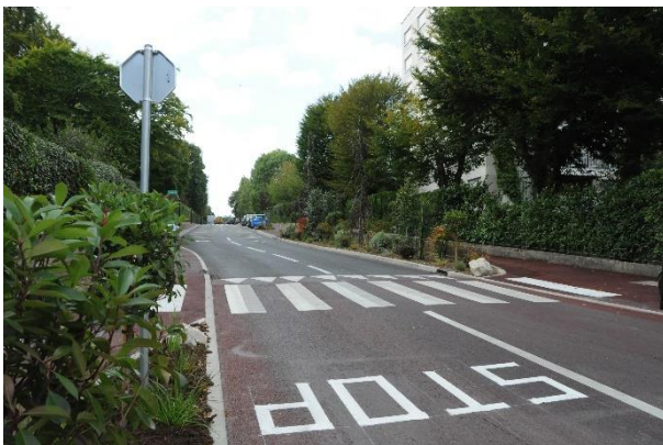
Photo 1 : Pavés podotactiles au niveau d'un passage piéton Rue du 19 janvier.
