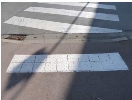
Les marquages podotactiles encastrés présentent l'avantage d'être durables et facilement identifiables.
