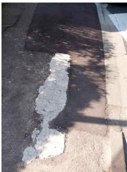
Les revêtements podotactiles en résine s'usent rapidement, se décollent et peuvent être dangereux en constituant un obstacle dans les franchissements. Il est également important de veiller à leur réfection lors de travaux de trottoirs.
