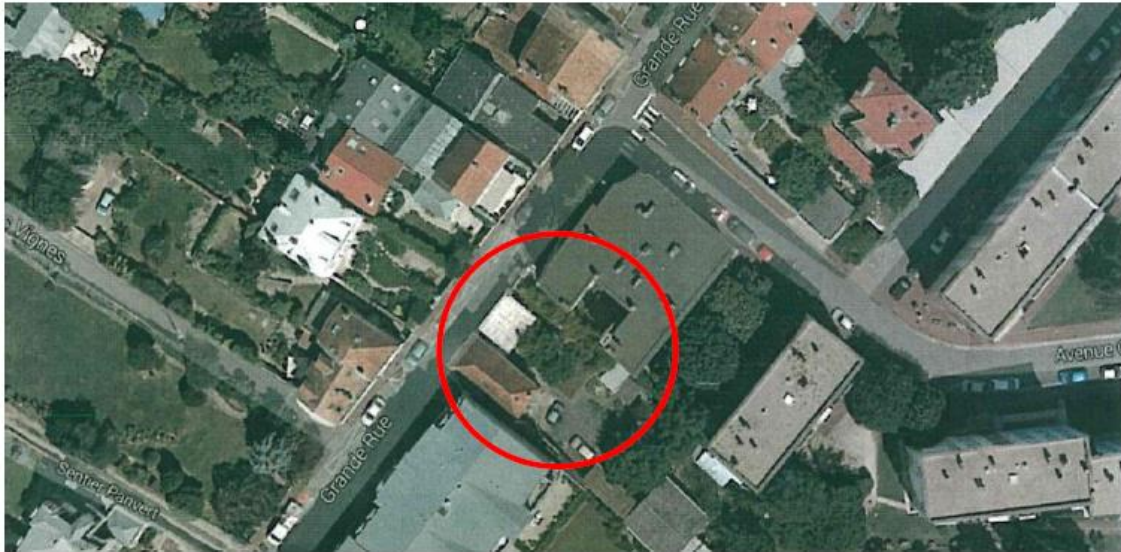
Figure 2-16 : Localisation du site pressenti pour le projet d'aménagement de la Grande Rue Source : PLU commune de Garches 2020
